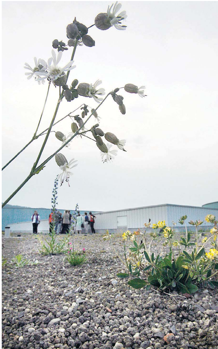
Erste Pflanzen spriessen auf dem kargen Boden des Zentrumsdaches.
